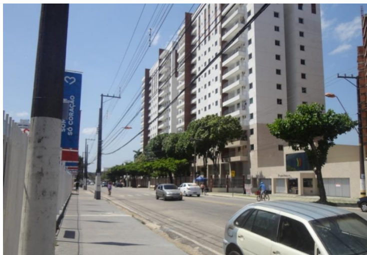
Figura 32 - Construção de novos edifícios na avenida
