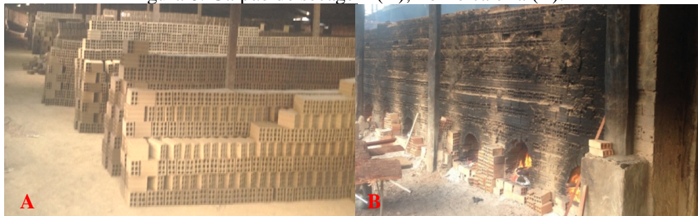
Figura 6: Galpão de secagem (A); Forno caieira (B).
