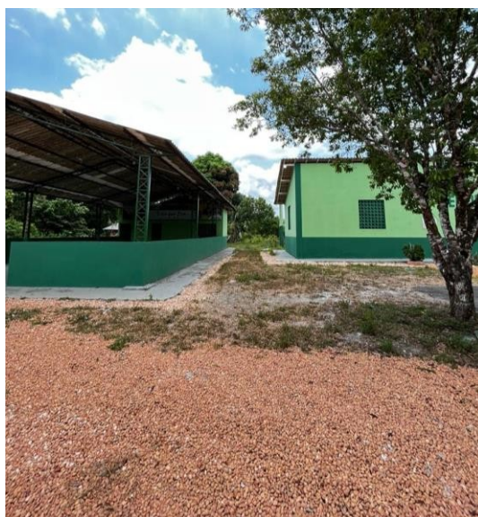
Figura 6: Caminho de acesso à instalação cozinha comunitária.
