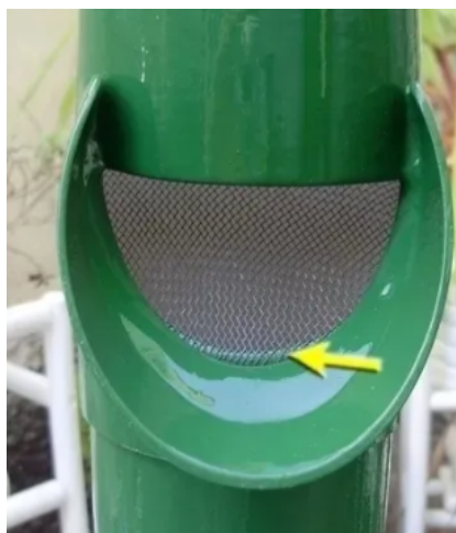
Figura 20 - Filtro para água da chuva.
