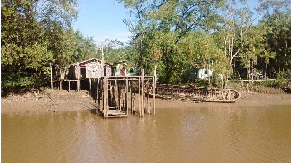
Figura 32 – Moradias do Combu sustentadas por madeiras.
