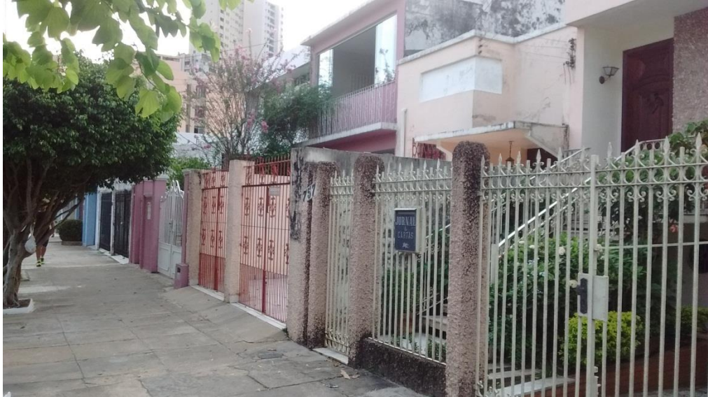
Figura 23 - Proteção de grades e muros.
