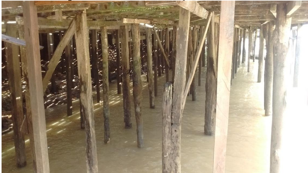
Figura 19 - Estrutura de sustentação das moradias.
