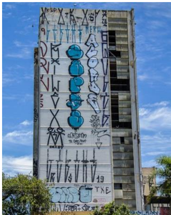
Figura 7 - Pichação em um prédio abandonado.
