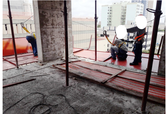
Figura 31 – Operação de soldagem I
