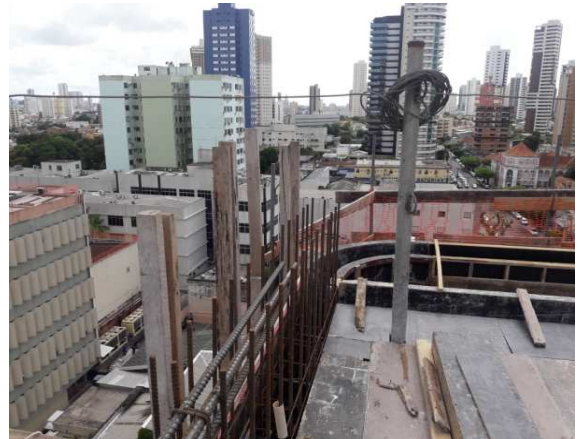
Figura 29 – Pontas dos vergalhões de aço
