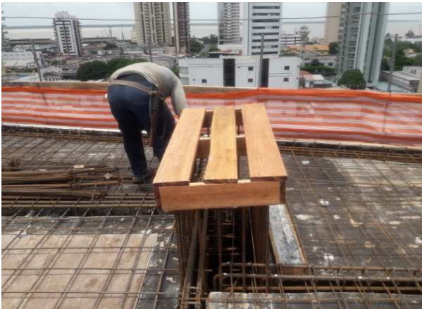
Figura 28 – Caixa protetora das pontas dos vergalhões
