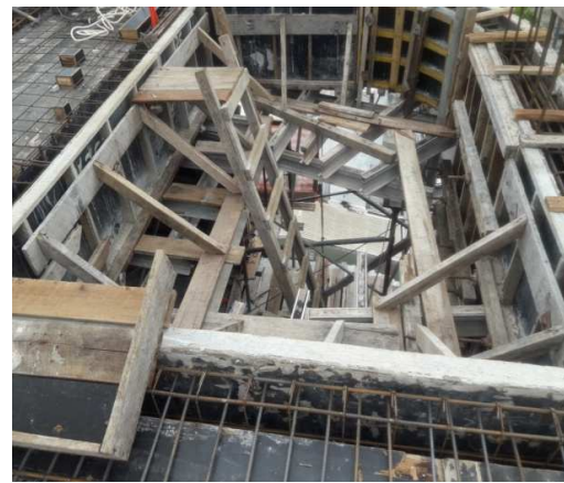
Figura 38 – Escada manual II
