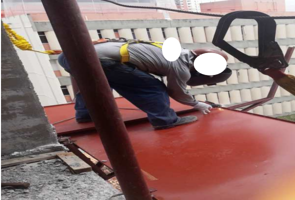
Figura 30 – Operação de soldagem I
