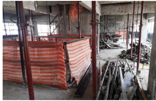
Figura 42 – Caixa dos elevadores
