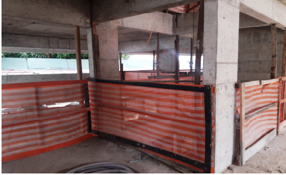
Figura 41 – Guarda-corpo e rodapé
