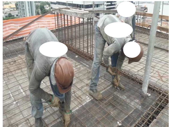
Figura 27 – Dobragem de vergalhão II
