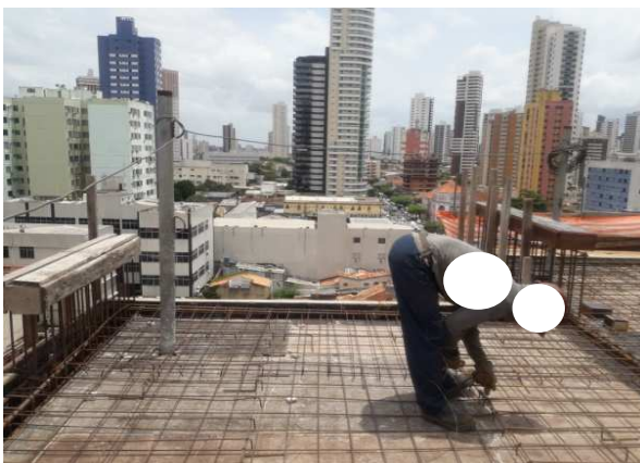
Figura 26 – Dobragem de vergalhão I
