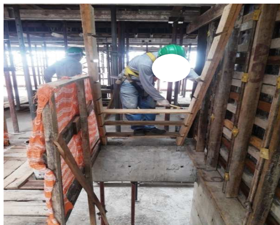
Figura 34 – Construção da escada
