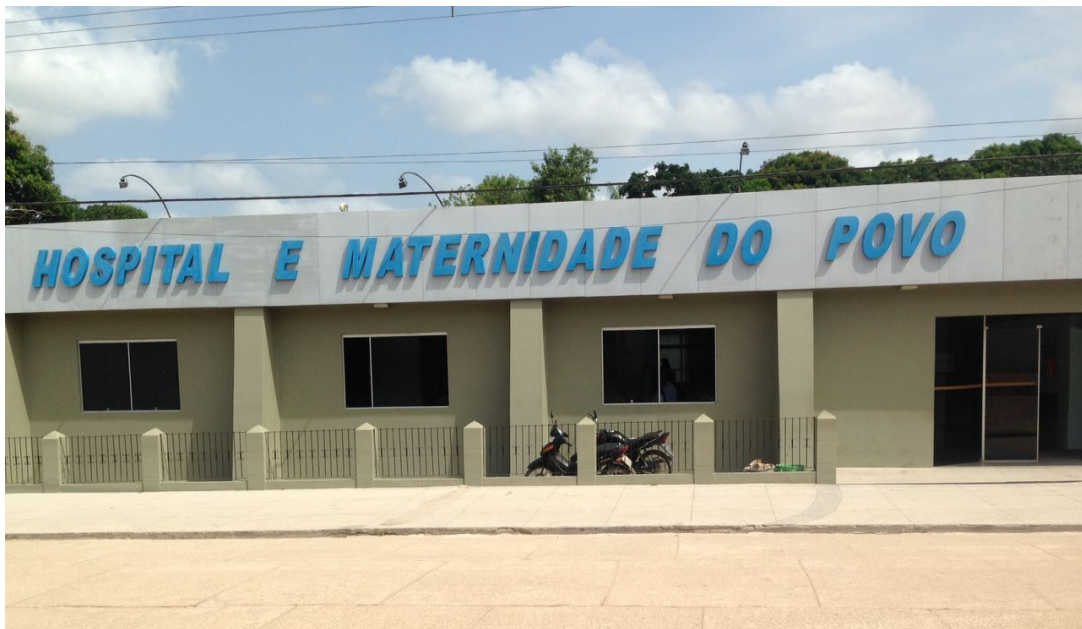
Figura 12: Faixada do Hospital e Maternidade do Povo
