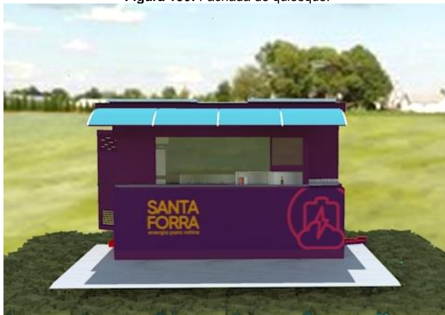
Figura 150: Fachada do quiosque.
