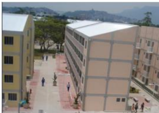
Figura 21:Edificação PAC em Manguinhos, RJ
